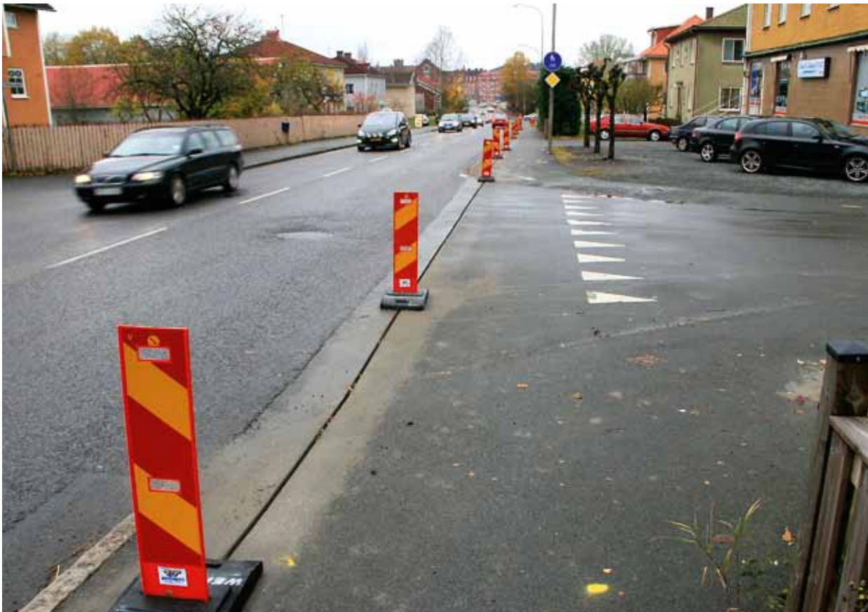
Man kan arbeta även genom större vägkorsningar utan nämnvärda hinder i trafiken. Det frästa spåret kan korsas utan att orsaka skador på vare sig fordon eller kanalisationsrör, och trafiken kan omedelbart släppas fram.
